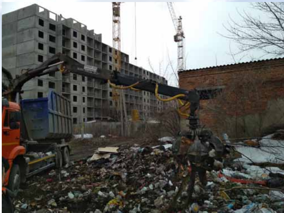
Рис. 12.3. Ликвидация свалки по ул. Рябиновая, д. 2
