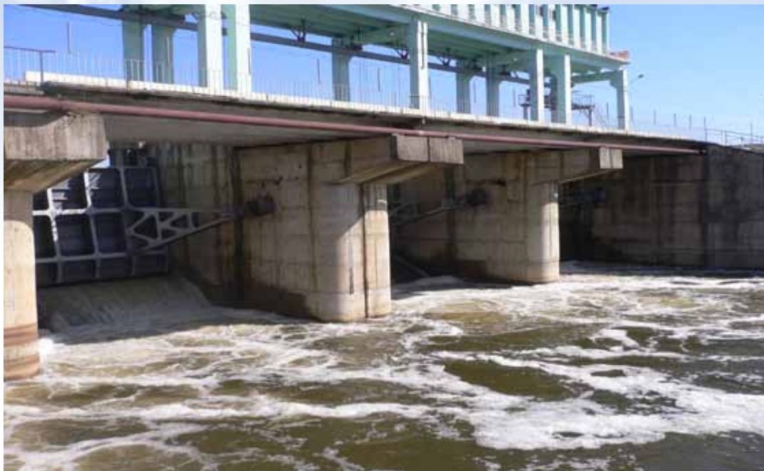
Рис. 15.7. Гидроузел Курского водохранилища
